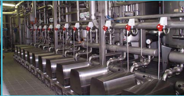
CIP und SIP Kreiselpumpen für Produktionswasser Lebensmittel- und Pharmaindustrie
